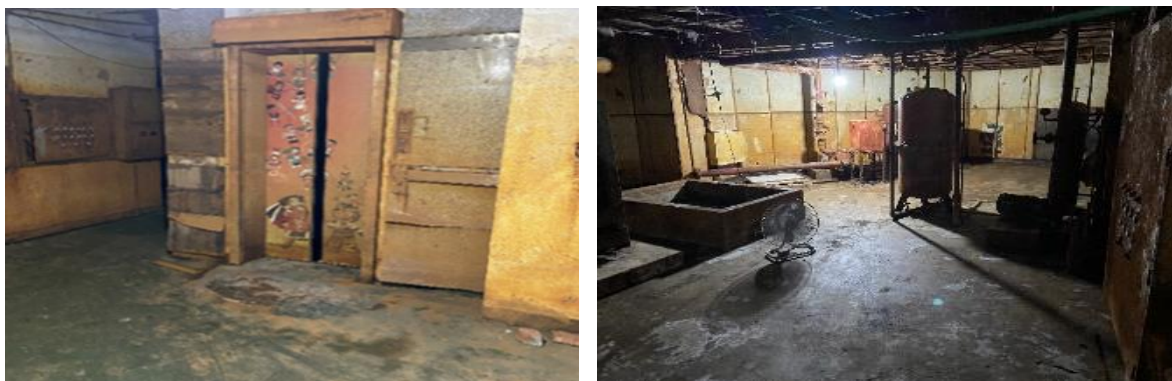
地下二樓之電梯遭地下水淹沒損壞（左）；地下二樓之機電設施損壞（右）。
