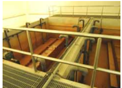
圖 1：損壞及閒置之砂濾池處理單元 (99.4.15 拍攝)
