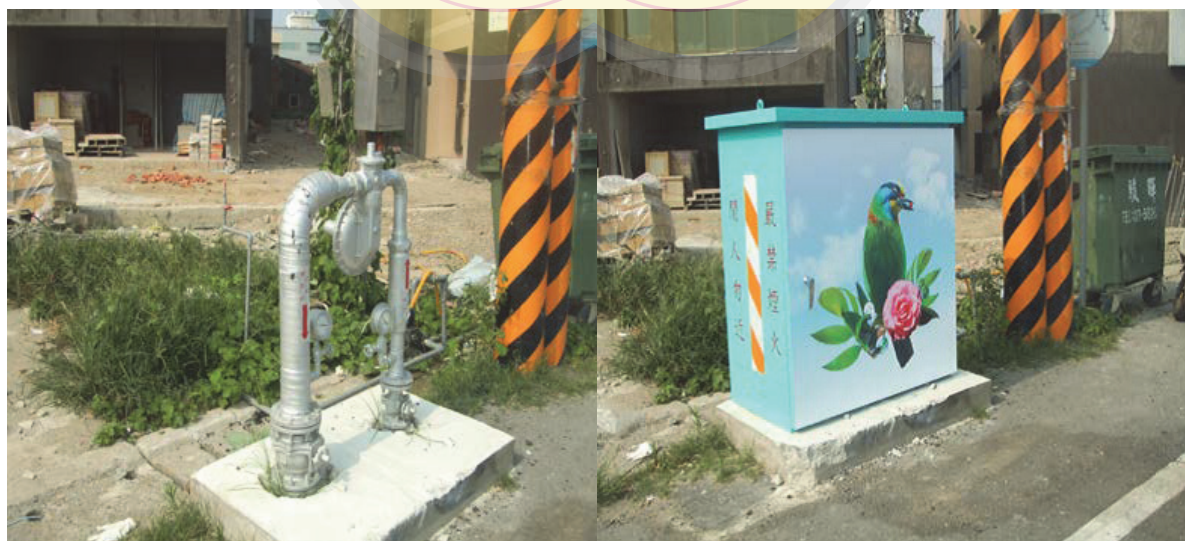
新竹縣路邊整壓設備防護箱設置前後情形 資料來源：新竹瓦斯公司提供。
