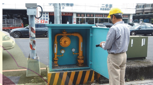
新竹瓦斯公司專人檢測路邊整壓設備情形 資料來源：105 年 11 月拍攝。
