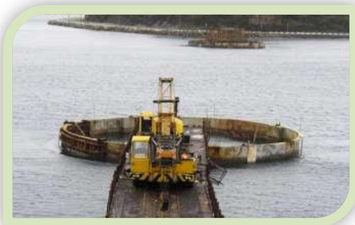
望安將軍橋橋墩柱施工
