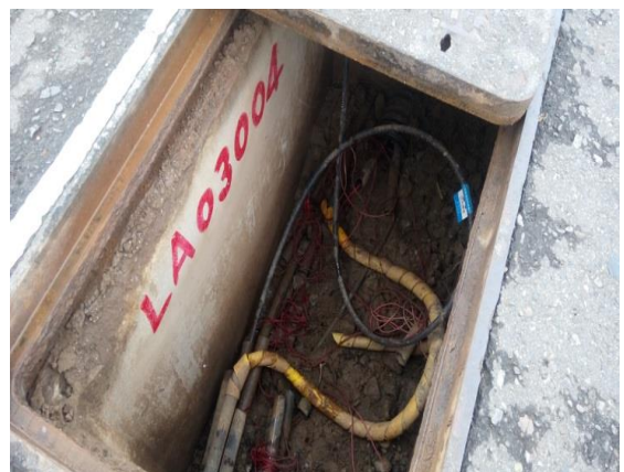
圖 7 太保市故宮東路寬頻手孔佈纜情形
