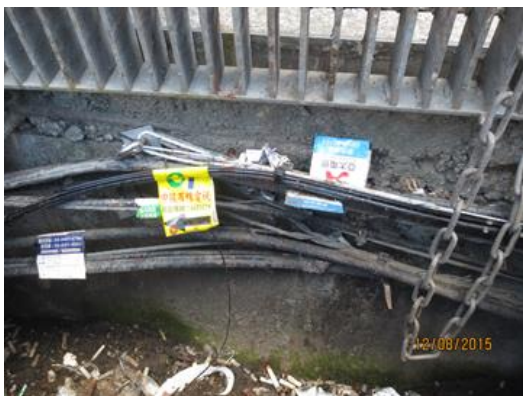
圖 11 埔里鎮和平東路排水溝暫掛纜線情形
