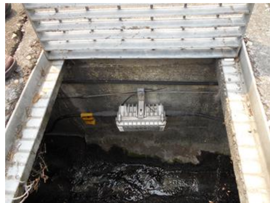
圖 12 竹山鎮前山路排水溝暫掛纜線情形
