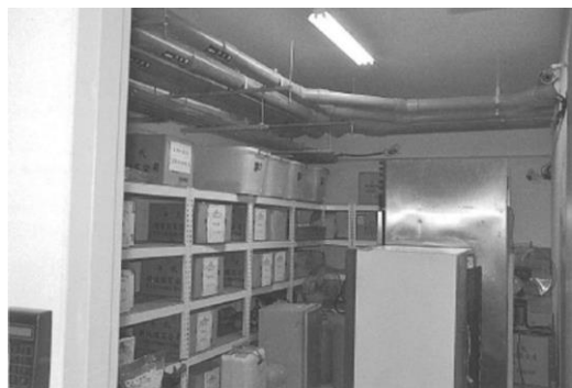
圖 3 證物室污水管線裸露架設情形
