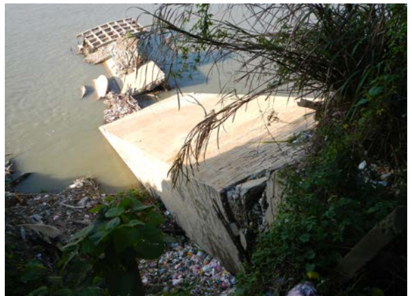
圖 2 土城區成功街截流箱涵斷裂沉入河道
