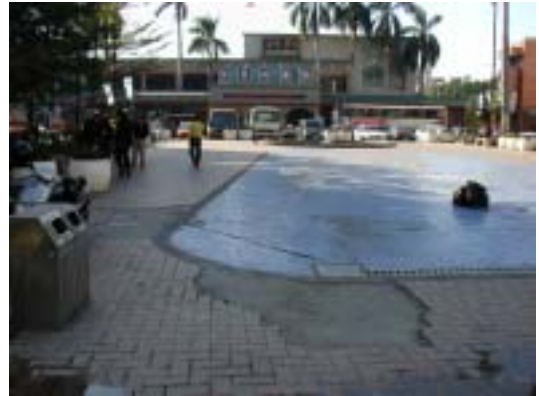
員林火車站人行步道地磚損壞
