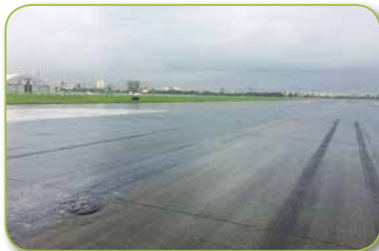
高雄機場跑道道面老化遲未整修情形
