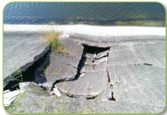
嘉義縣東港滯洪池圍堤崩塌及砂土流失
