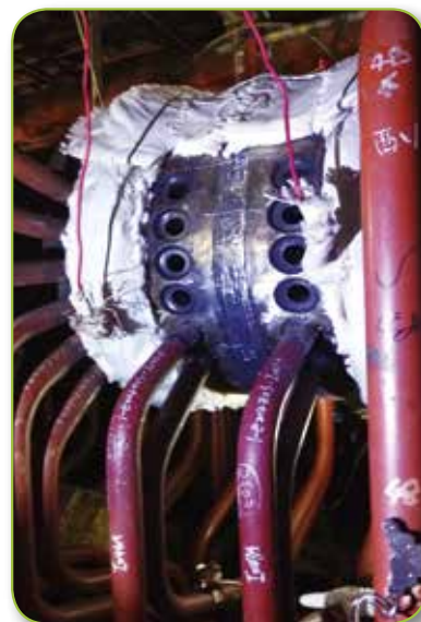
大林電廠更新改建計畫 鍋爐銲道瑕疵修補情形
