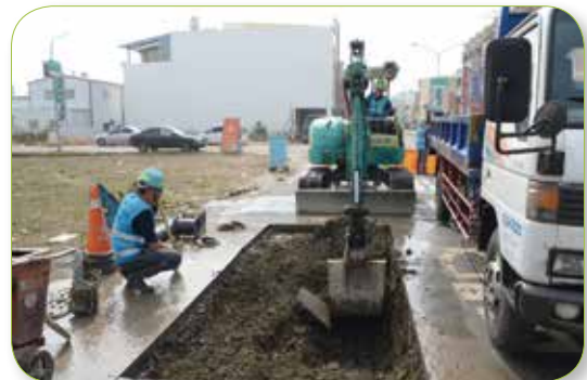
自來水管線汰換情形
