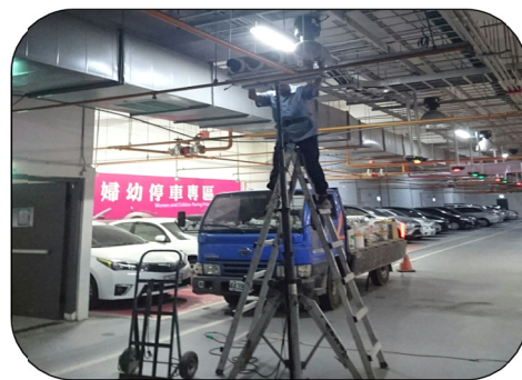
地下室空氣噴流設施機台設置
