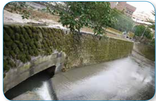
H 幹線雨水下水道排水出口迴水情形
