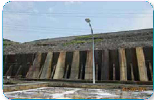
舊有掩埋場擋土牆邊坡上方底渣及土石沖刷
