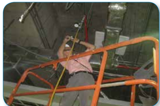
臺北車站大樓消防撒水管路壓力測試
