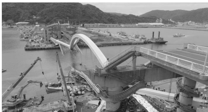
圖 1 南方澳大橋斷裂情形
