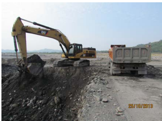
圖 11 疏濬工區開挖土石情形
