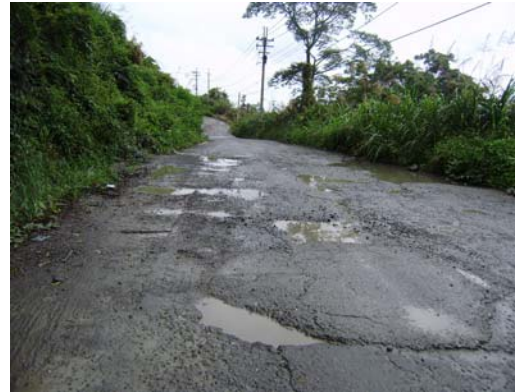
圖 15 沿線路面損壞多處坑洞
