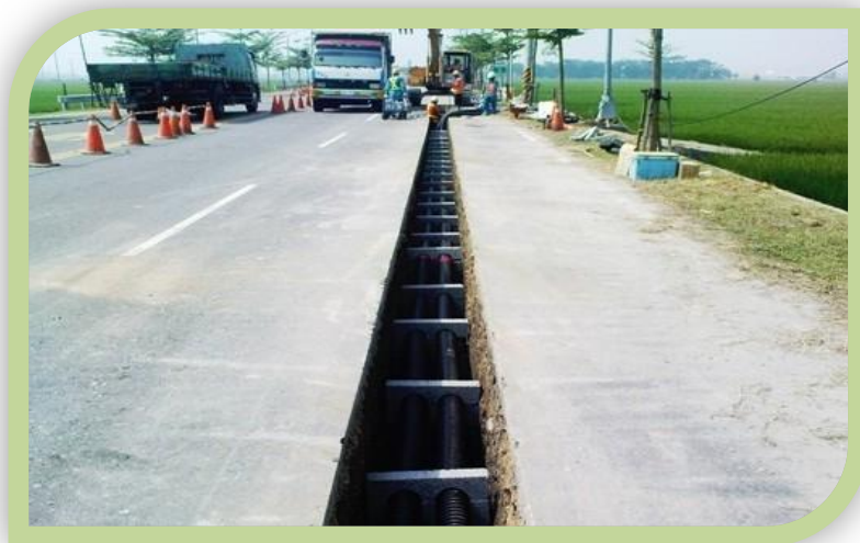
寬頻管道施工情形
