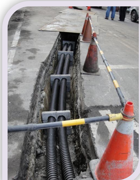
開挖路面埋設寬頻管道
