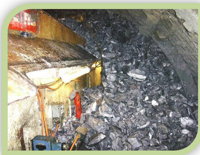
台電公司辦理和平溪碧海水力發電工程計畫之頭水隧道 TBM 機具受困情形
