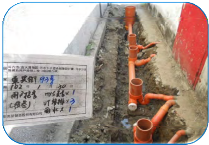
斗六市東興街污水下水道接管施作情形
