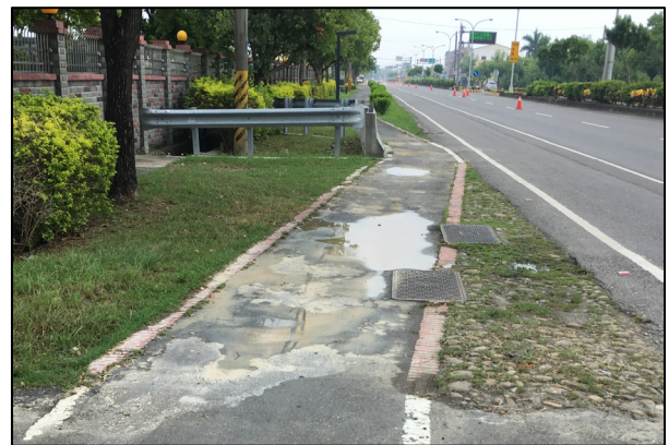
省道台一線部分自行車道柏油路面破損
