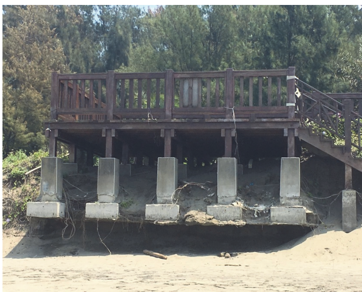
新月沙灘木棧道觀景台基礎遭沖刷掏空情形
