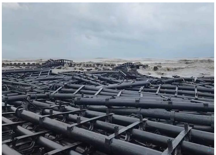
圖 13 浮臺無法抵抗強風而飄散屏東佳冬海岸
