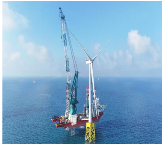
圖 9 離岸風機安裝情形
