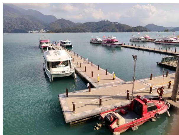
圖 8 日月潭電動船專用浮排
