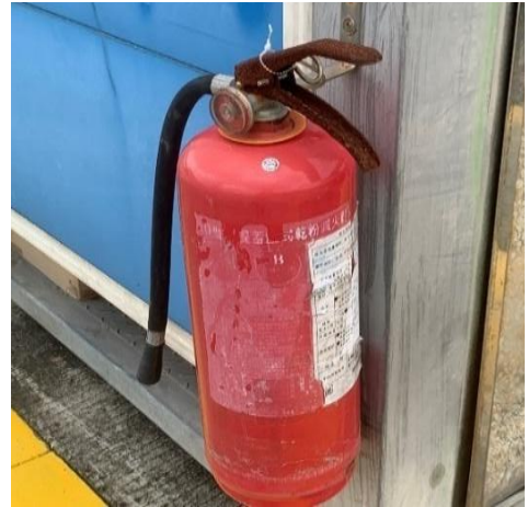
新北市新莊塔寮坑 1 區停車場 滅火器壓把已鏽蝕 (113 年 10 月 10 日自行拍攝)
