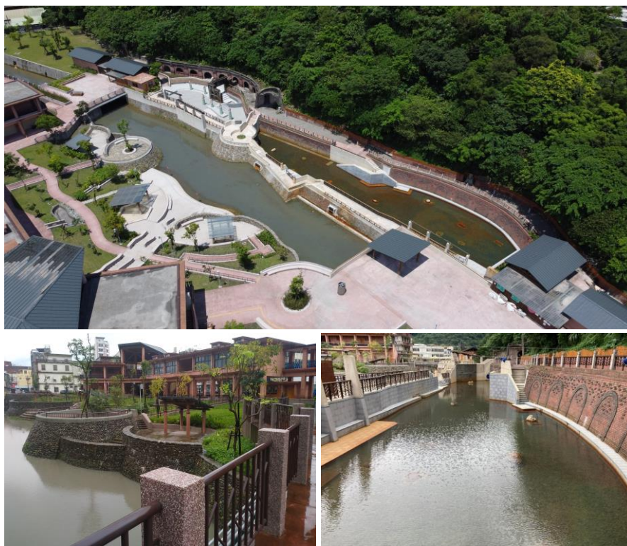
蘇澳冷泉公園園區現況
