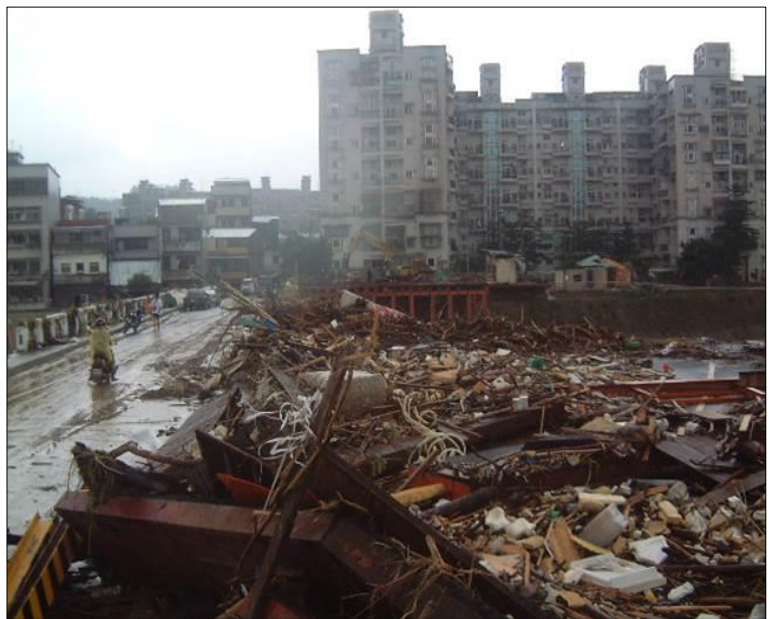
舊長安橋於納莉風災遭阻水雜物堆積現況
