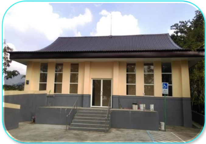
內埔鄉第十三公墓納骨塔完工照片
