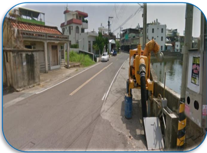
前池貯水空間容量不足
