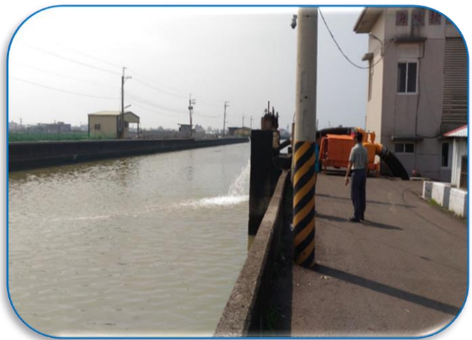
海埔社區需靠移動式抽水機將雨水排入區排
