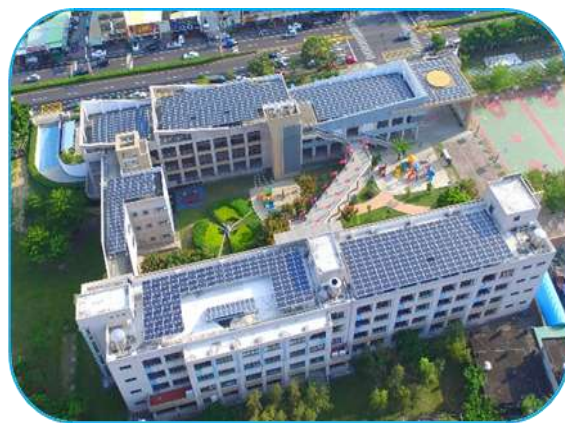
公有建築物設置太陽光電系統
