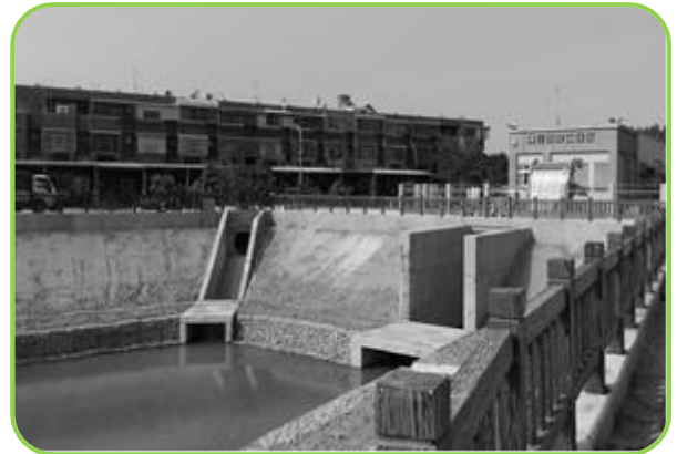
嘉義縣勞工住宅社區調節池及抽水站
