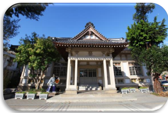
彰化市武德殿
