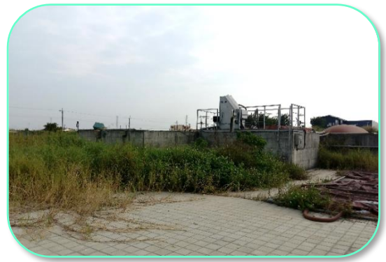
彰化縣綠金加值園區廢水處理場
