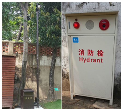
圖 1 赤崁樓防災設備設施機具
