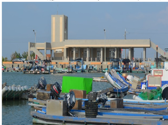
圖 4 北門蘆竹溝漁港多功能漁市大樓
