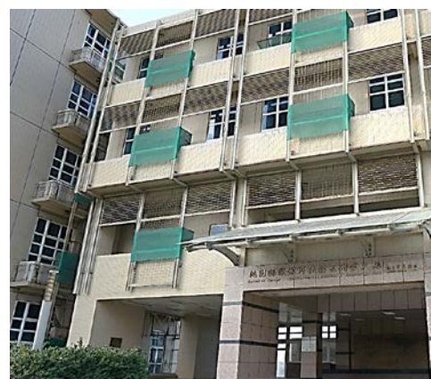
桃園市環保科技園區研發大樓
