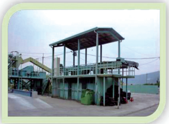
南投縣水里鄉營建剩餘土石方 資源堆置場閒置
