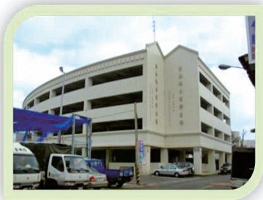
屏東縣恆春鎮停一立體停車場 部分樓層閒置
