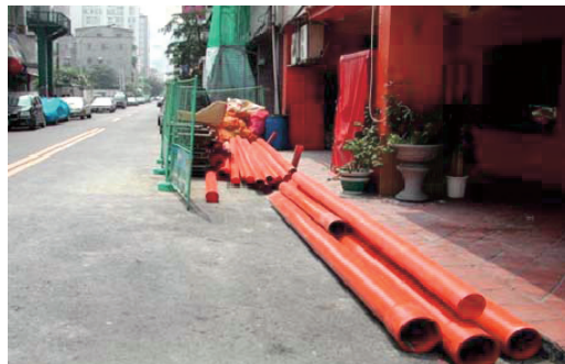
高雄市污水下水道用戶接管工程
