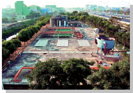
臺南市虎尾寮污水處理廠閒置
