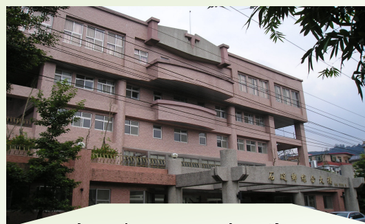
臺北縣石碇鄉綜合大樓
