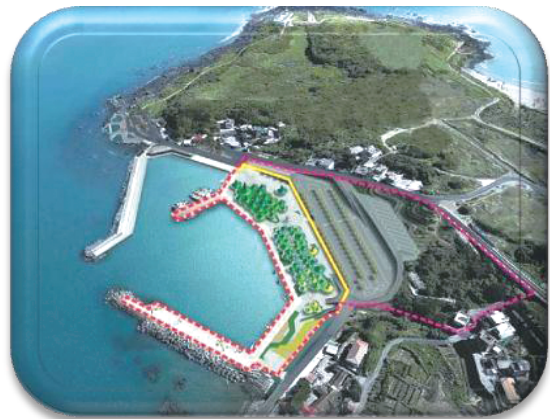
前臺北縣富基漁港整建工程進度落後
