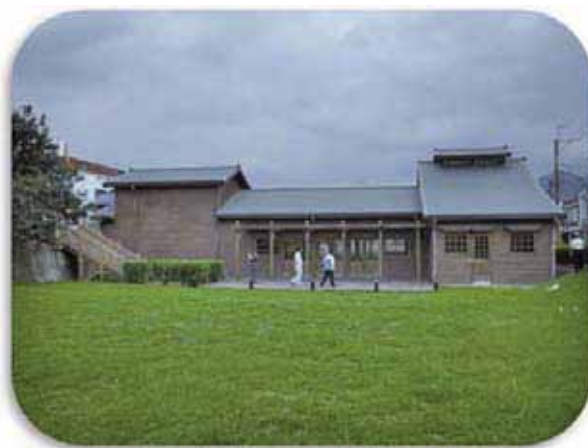
臺東縣鹿野鄉水車碾米廠及煙樓
