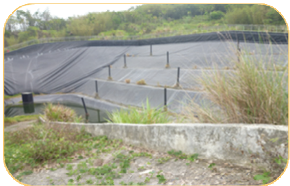
集集鎮區域性垃圾衛生掩埋場閒置情形 (南投縣政府環境保護局提供)
