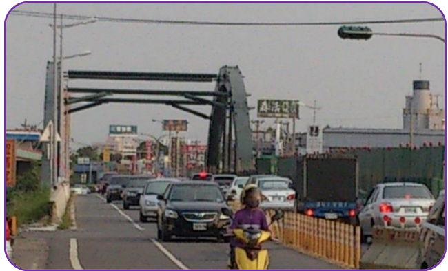
雲林縣縣道158線平和橋改建工程施工情形
