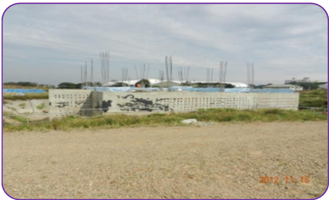
桃園市中壢污水處理廠進流抽水站外觀
