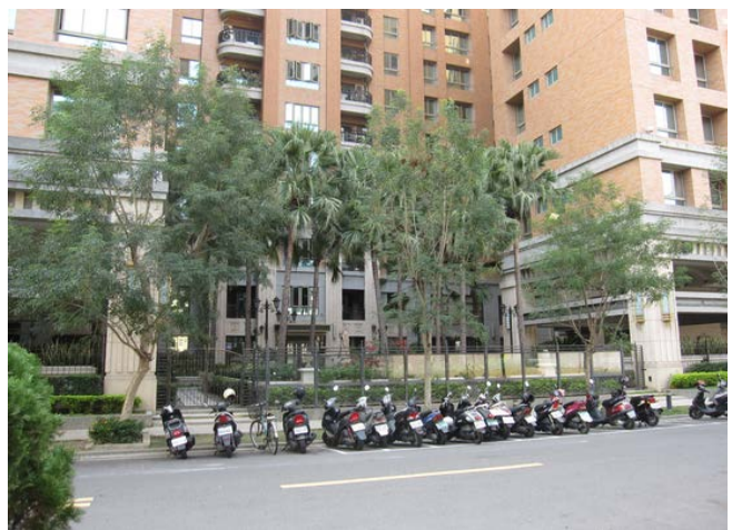
高雄市建物開放空間違規設置圍籬情形 (102 年 3 月 11 日拍攝)
