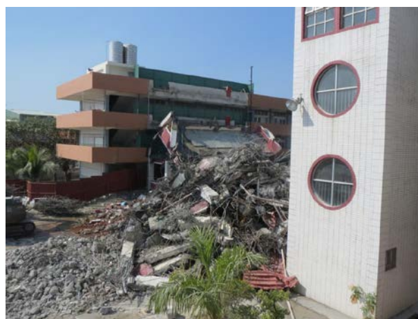
安慶國小 D 棟教室拆除情形 (臺南市安慶國民小學提供)
