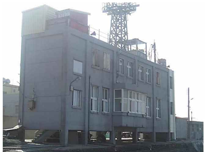
未取得建築執照建築物—台子港安檢所 （海岸巡防署提供）
