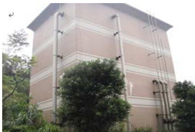
臺北市轄區內加壓受水設備之高地配水池 (臺北自來水事業處提供)
