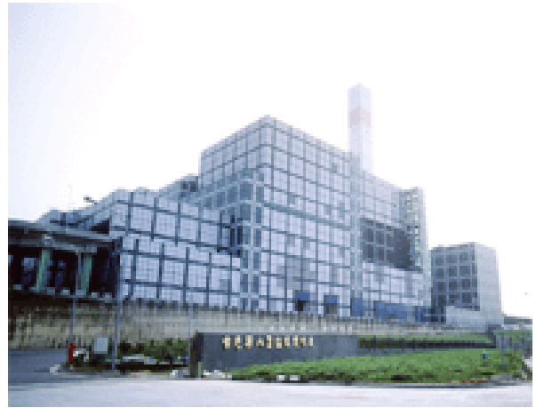
新北市八里垃圾焚化廠外觀 (擷取自新北市八里垃圾焚化廠網站)
