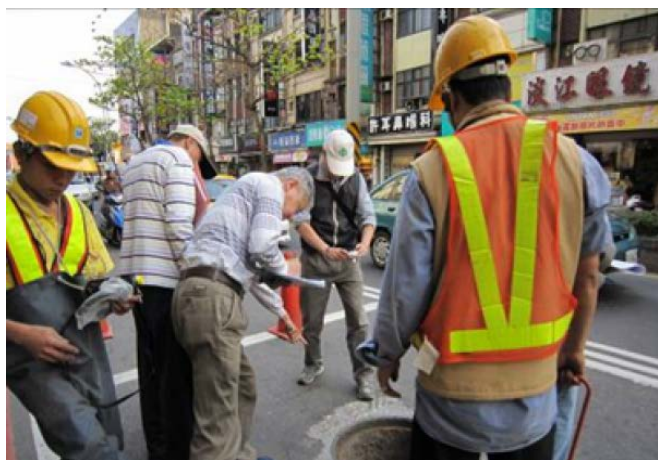
新北市雨水下水道清淤及人孔抽查情形 (擷取自新北市政府水利局網站)
