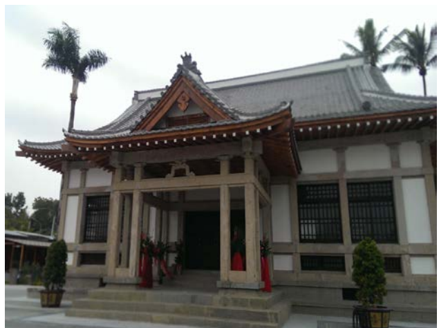
高雄市旗山武德殿-修繕後外觀 (高雄市旗山區公所提供)
