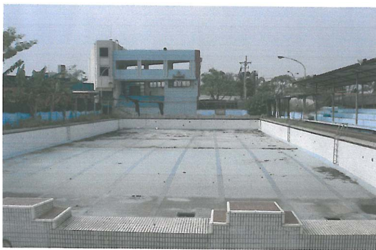
彰化縣大村鄉立游泳池拆除前照片 (彰化縣大村鄉公所提供)
