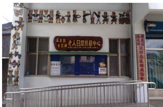
屏東縣泰武鄉武潭村日間照顧中心 (屏東縣長期照護管理中心提供)
