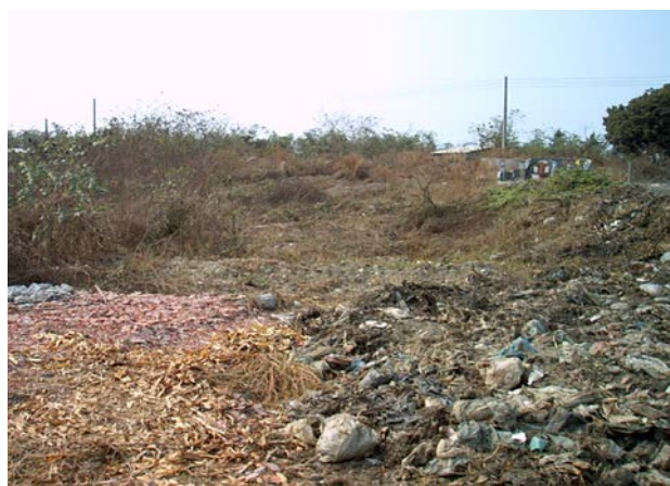
高樹鄉埔羌崙段 1815 地號土地坑洞 (屏東縣政府水利處提供)
