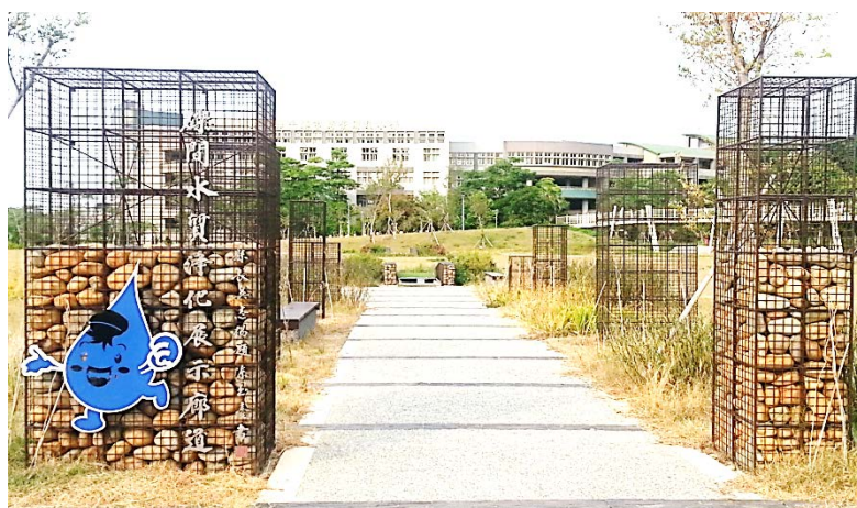
桃園市礫間水質淨化展示廊道入口 (審計部桃園市審計處拍攝)
