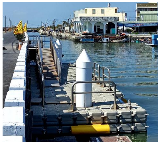
臺南市下山漁港 (臺南市政府農業局提供)
