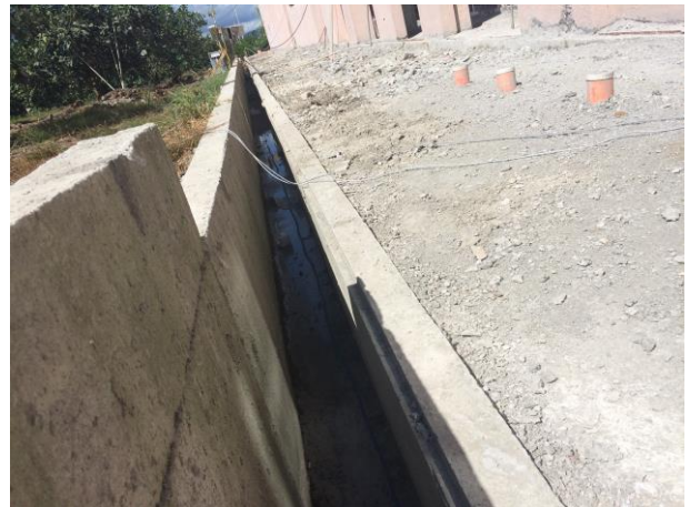
花蓮縣營建工地稽查情形 (花蓮縣環境保護局提供)
